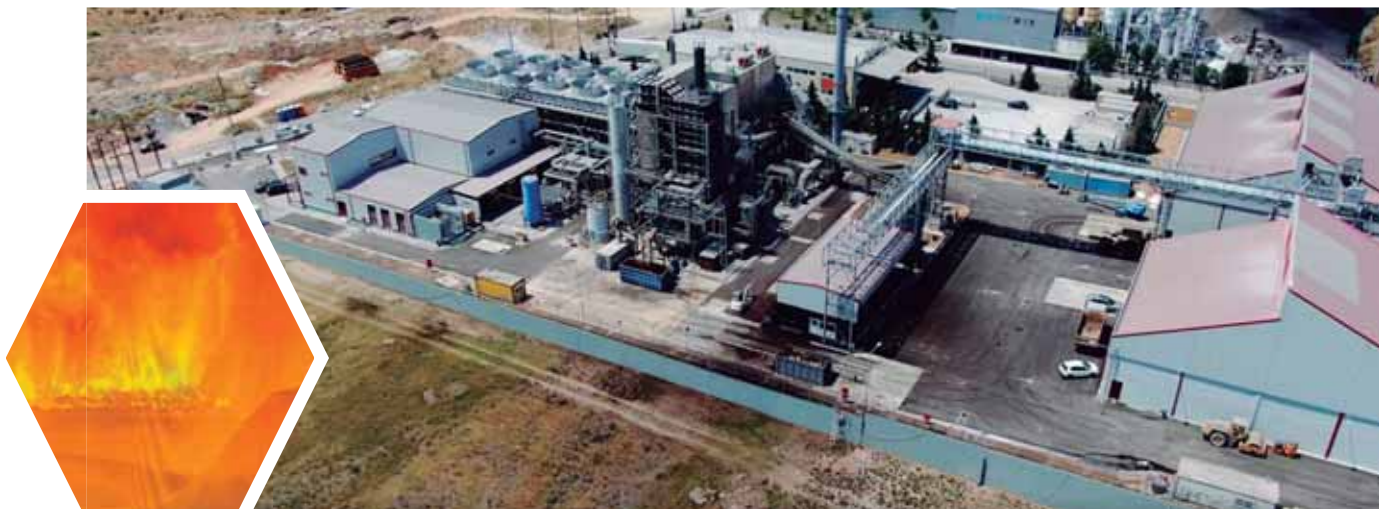
FIGURE 15 ET 16. Photo aérienne de la centrale électrique à biomasse de 5 MWe de VIOPAR S.A. in Volos, Greece. Source: 27 VIOPAR
